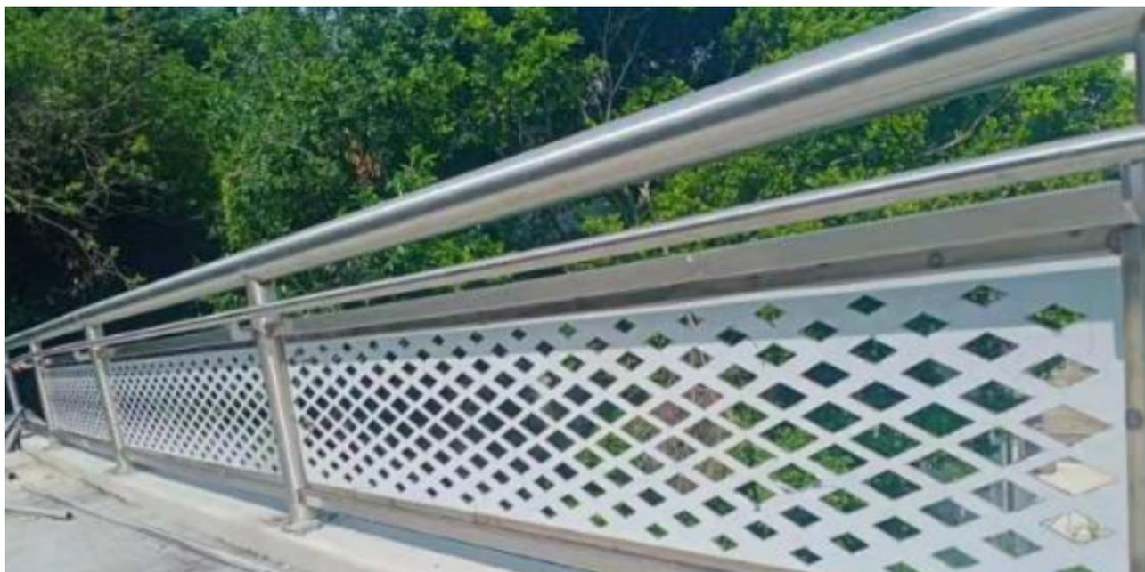
放置铁艺制品的地方应是硬物不常碰到的地方;放置铁艺制品的地面还应保持平整，铁艺护栏在安装时应保证其牢固，若摇晃不稳，日久会使铁艺护栏产生变形，影响铁艺护栏的使用寿命。2.要定期除尘。户外尘埃飞扬，日积月累，铁艺设施上会落上一层浮尘。它会影响铁艺的色泽，进而导致铁艺保护膜的破损。所以应定期擦拭户外铁艺设施，一般以柔软棉织品擦拭为好。3.要注意防潮。如果只是一般的户外空气湿度。您可以放心铁艺护栏的防锈性。如逢大雾天气，应用干棉布擦拭铁艺上的水珠；若逢雨天，应于雨停后及时把水珠擦干。因我国大部分地区酸雨肆虐，雨后应立即把残留在铁艺上的雨水擦干。4.铁艺护栏上若不慎沾上酸(如硫酸、食醋)、碱(如甲碱、肥皂水、苏打水)，应立即用清水把污处冲净，再用干棉布擦干。5.消除锈迹如果铁艺护栏生了锈，不要自作主张用砂纸打磨。锈迹较小较浅的，可用棉纱蘸机油涂于锈处，稍候片刻，用布揩擦便可消除锈迹。若锈迹已经扩大变重，则应请有关技术人员来维修。总之，只要掌握了有关维护保养的常识，在日常生活中注意保护铁艺护栏，便可延长它的寿命，使您精心挑选的铁艺精品长久地陪伴着您。
